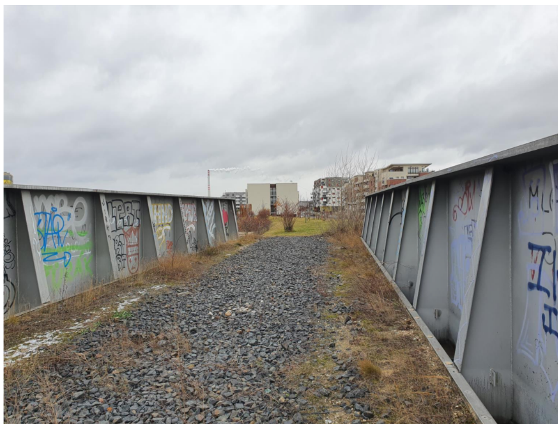
DOLNÍ MĚCHOLUPY – budoucí hlavní pěší cesta od zast. PRAHA – MALÝ HÁJ
