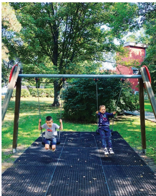
Doplnili jsme dopadové plochy všude, kde to bylo třeba.
