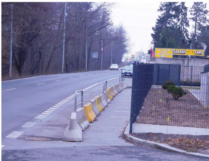
Stav po instalaci
